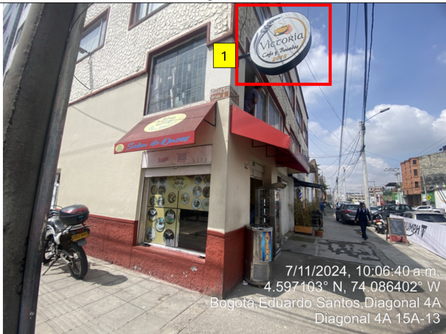
En la cual se evidencia un (1) elemento PEV volado de la fachada, identificado con el número 1.
